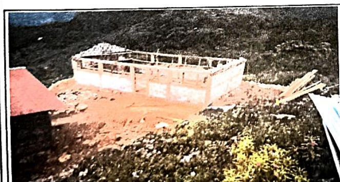
Foto 5: se observa unos 70% por ciento el trabajo
