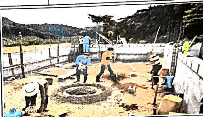
Foto 2: se observa el avance el trabajo
