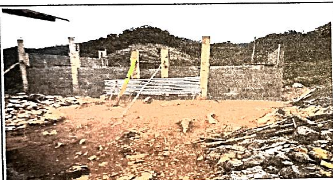
Foto 3: se observa el avance el trabajo
